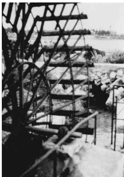
Vodeno kolo na otoku Kefaloniji sagrađeno na kanalu kako bi se voda koja teče prema unutrašnjosti iskoristila za dobivanje struje. Razina vode spusti se oko dva metra ispod morske razine prije nego što stigne do kola, a nakon toga se spusti još nekoliko metara prije nego što uđe u pukotinu
